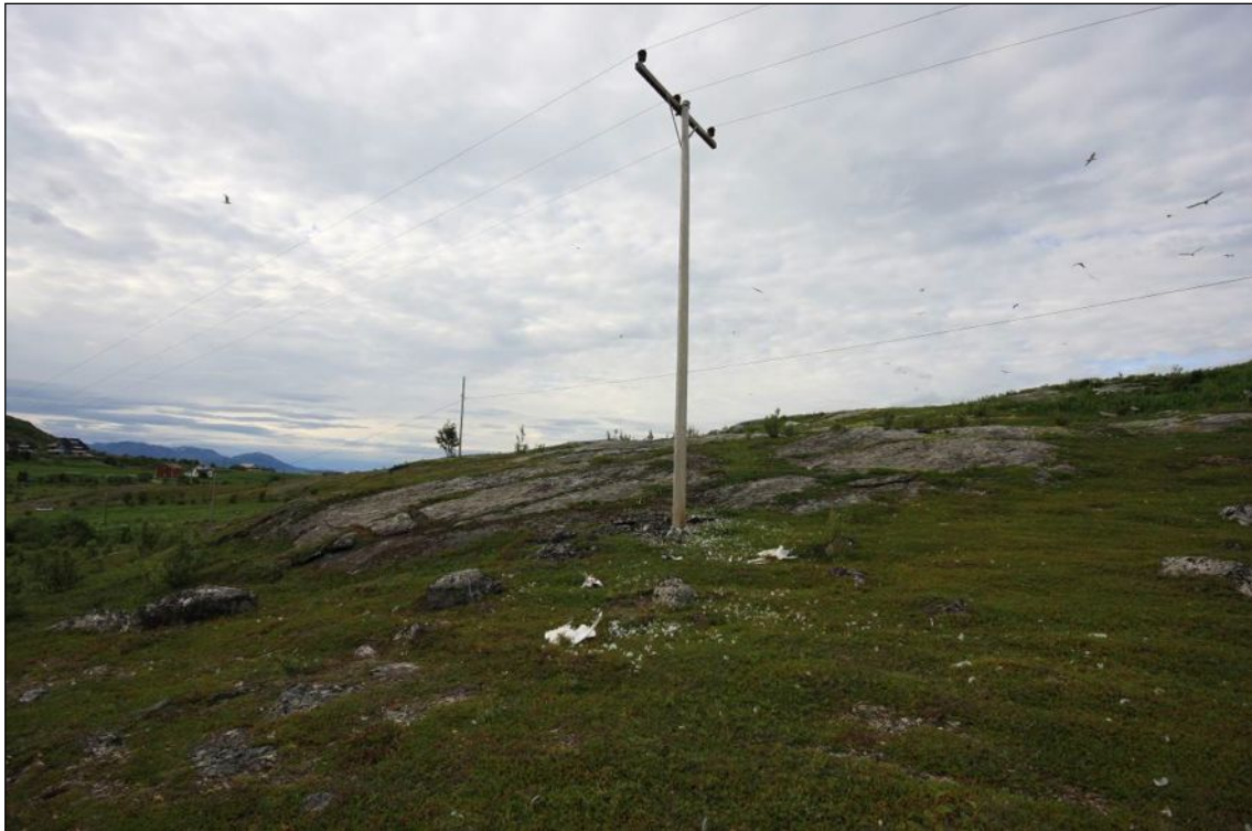
Fig 11. Måkekoloni ved Kongshusskaget på Årøya. 22 kV kraftlinje går gjennom kolonien. Rundt masten i bildet ble det funnet 14 gråmåker som enten har fløyet på linjen eller har dødd ved elektroksjon. Foto: Ingve Birkeland.
